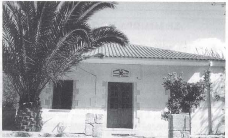
Το ανανεωμένο κτίριο του Αστυνομικού Σταθμού Αρμένων, μια υπηρεσία που καλύπτει όλα τα χωριά του νεοσύστατου Δήμου
